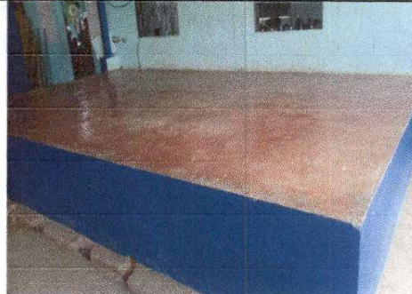
FOTO 2: Sustitución de piso cerámico
