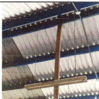
FOTO 6: Instalación de unidades luz (incluye interruptor, ducto y cable eléctrico)
