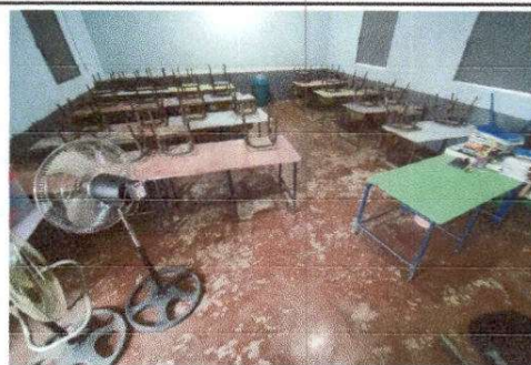
FOTO 2: Sustrucción de piso cerámico
