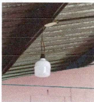
FOTO 6: Instalación de unidades luz (incluye interruptor, ducto y cable eléctrico)
