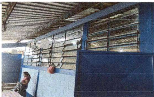
FOTO 5: Fabricación e instalación de balcones de hierro en ventana
